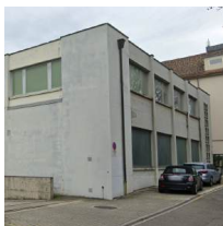
COPET 3 à démolir et reconstruire
