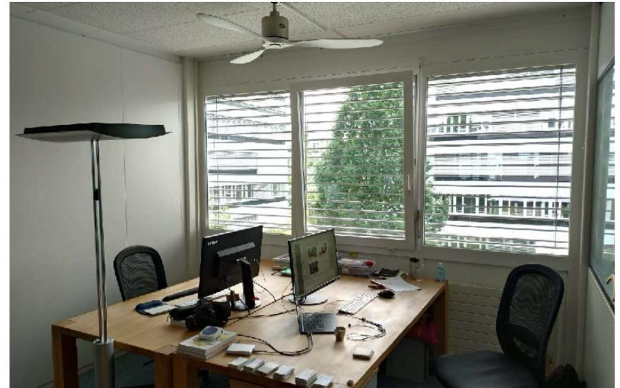
**Inertie (béton apparent au plafond) + Ventilation naturelle diurne et nocturne (fenêtre en imposte) + stores à lames + ventilateur plafonniers pour les jours de canicule**
