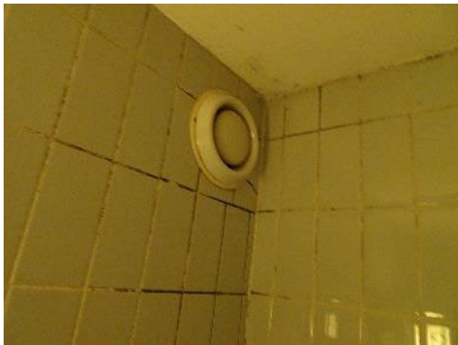
Moisissures dans les pièces humides malgré l'extraction. Débit insuffisant ou mal réglé
