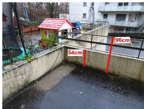
Parapet terrasses Non conforme
