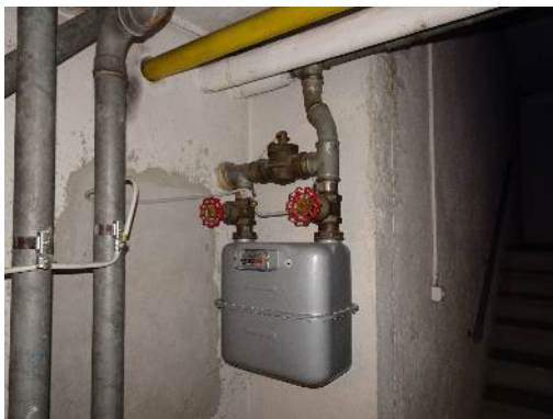
Avant-compteur ou ancien compteur de gaz non relevé, redondant.
