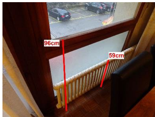
Garde-corps balcon Non conforme
