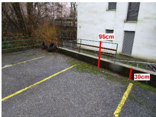
Garde-corps volée escalier Non conforme (dito escalier)
