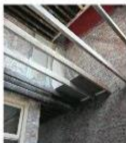
le plancher mis à nu
