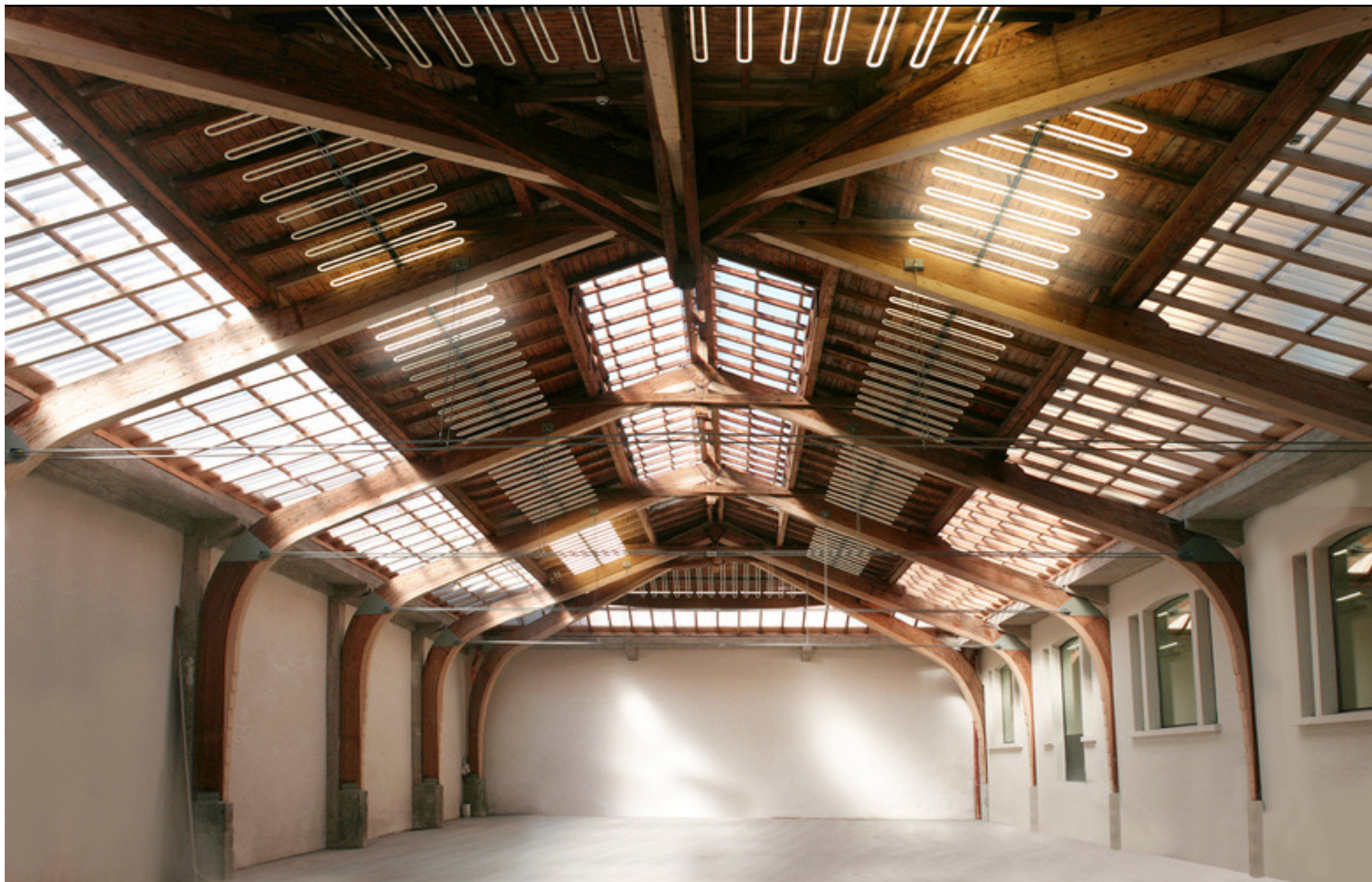
Ancienne usine Tobler à Lugano, réemploi et renforcement in-situ de la structure en bois lamellé-collé, reconversion de l'affectation industrielle en espace d'exposition et bureaux. (©Jachen Könz architecte)
