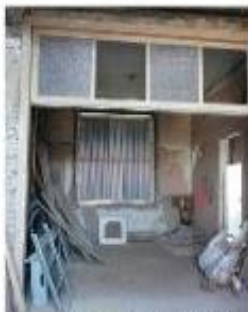
le rdc pendant les travaux
