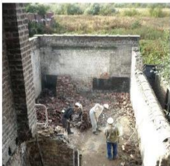
déconstruction des dépendances
