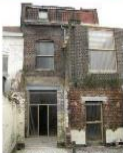
Facade arriere apres travaux
